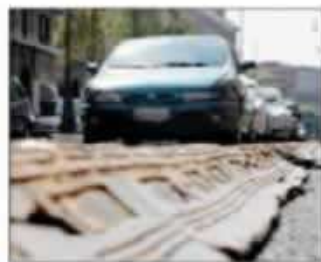
A destra i cordoli deteriorati in via Labicana, sotto in via del Tritone
